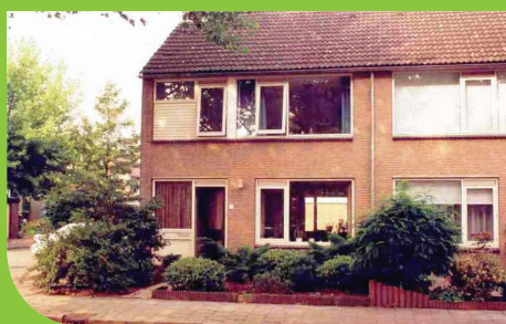
Aanblik voor de renovatie
