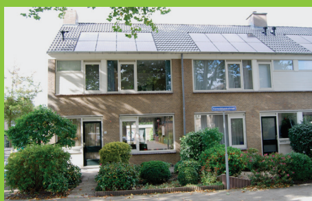
Aanblik na de renovatie
