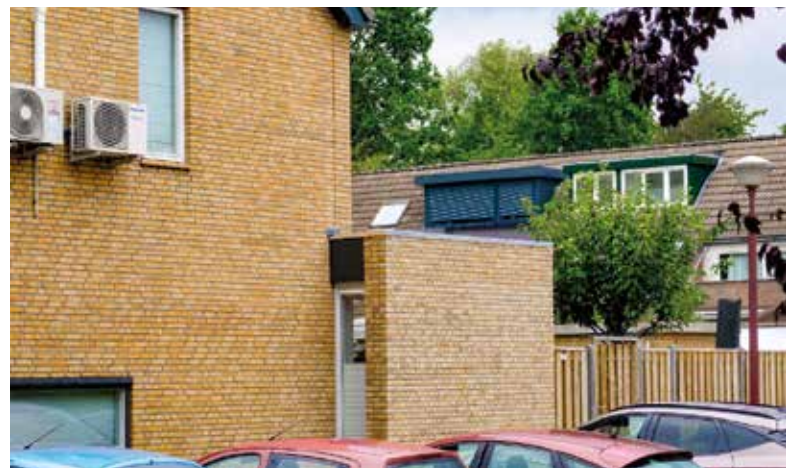
Iemand kan een dakkapel of -opbouw willen plaatsen.
